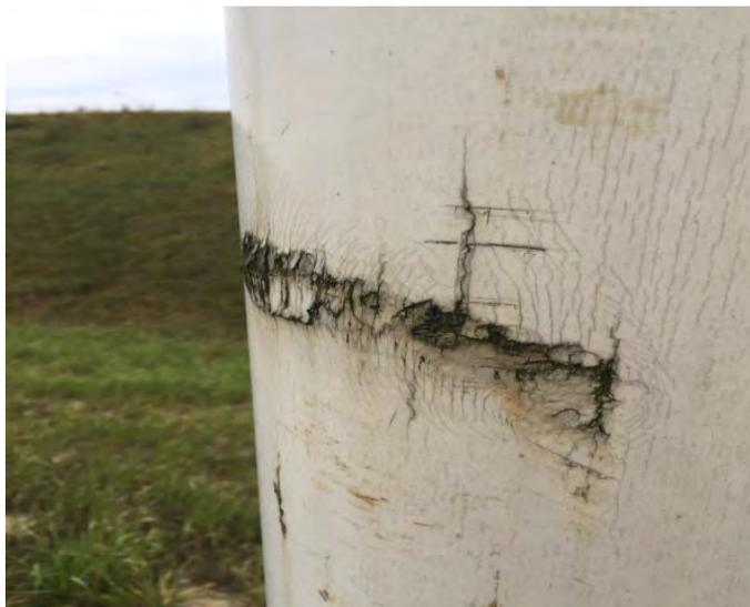
Отслоение материала в характерных узлах в результате действия вибрационных нагрузок на мост
